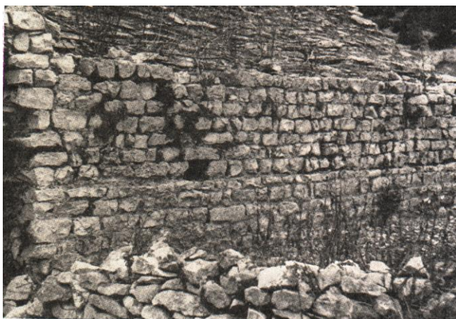
ZID RIMSKE CISTERNE NA ŽALU
